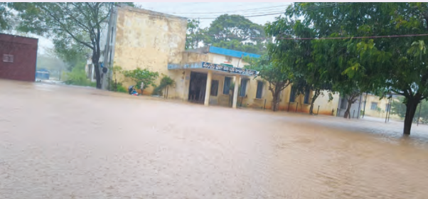
మండల ప్రజాపరిషత్ కార్యాలయం ముందు చేరిన వర్షపు నీరు
